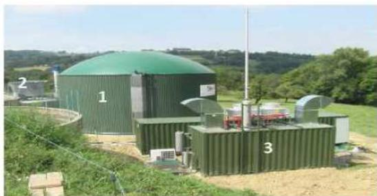
Le GAEC les Châtelets, sur la commune de Gruffy (74) est une exploitation agricole de type élevage bovin. Ce GAEC a souhaité développer une structure de méthanisation – cogénération, mise en service à l'automne 2009. Cette structure est constituée d'un digesteur en acier (1), d'une trémie d'alimentation (2) et d'un module de cogénération(3).
